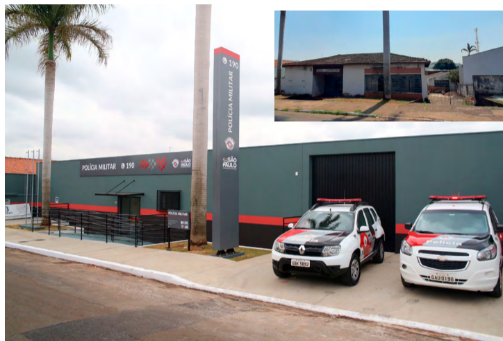
Entrega da obra aconteceu nesta semana; no detalhe como era antes o prédio sem as melhorias
