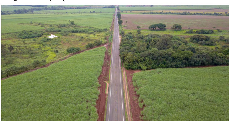
Via foi pavimentada e recebeu infraestrutura
